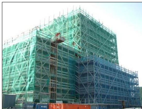
Verkpallar við Þjóðleikhúsið.
