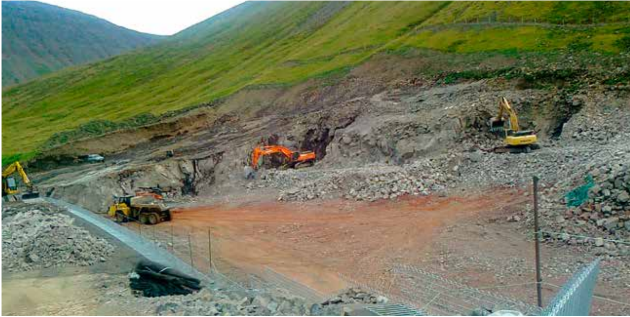
Mynd 2. Á framkvæmdatíma í ágúst 2012.
