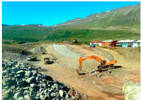
Mynd 9. Á framkvæmdatíma í júlí 2012.
