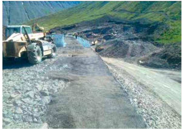
Mynd 8. Unnið að uppsetningu styrkingarkerfisins.
