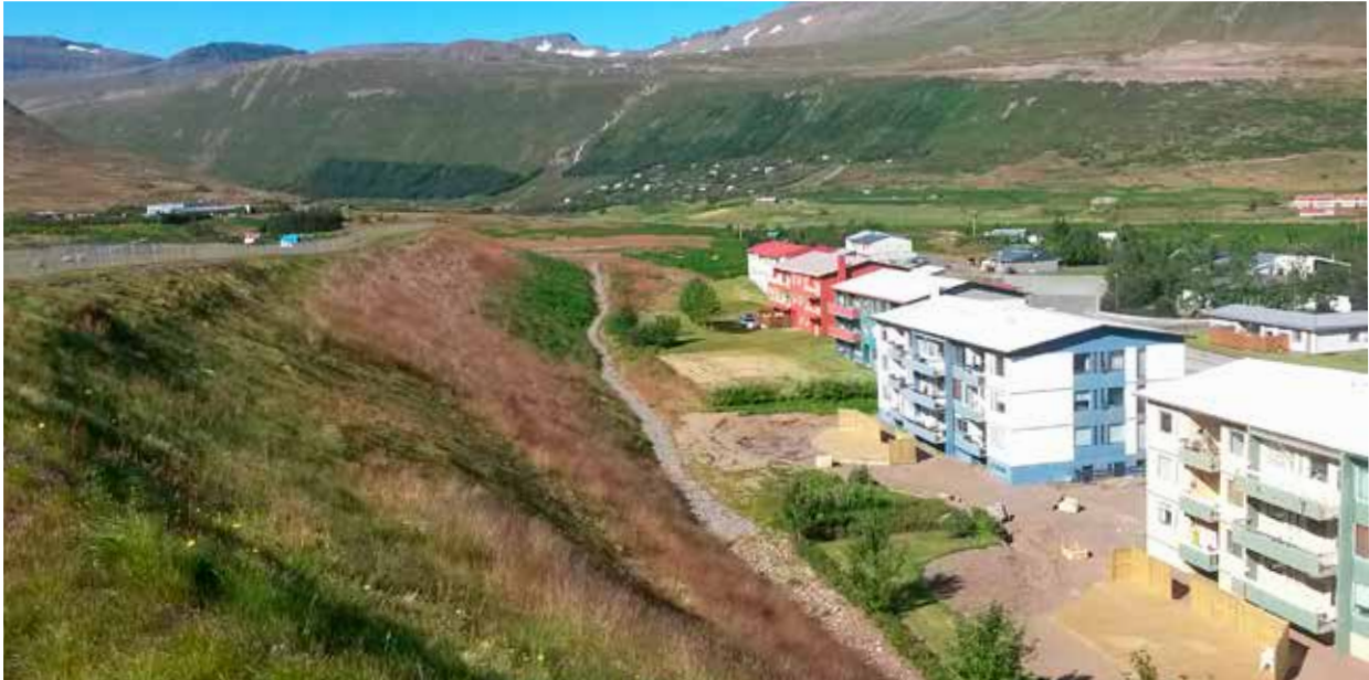
Mynd 1. Jarðvegsflái varnargarðsins hlémegin.
