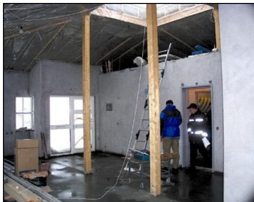
Mynd tekin 13.01. 2000. Lögreglustöð er að verða tilbúin undir tréverk
