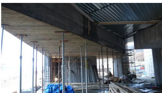
Mynd 26: Uppsteypu lokið, unnið að gustlokun
