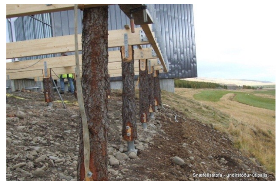
Mynd 46: Undirstöður útíþalls
