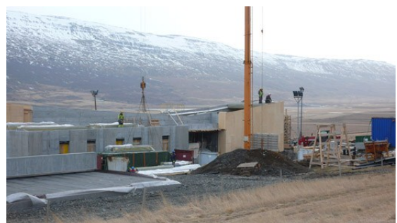
Mynd 22: Hús uppsteyppt
