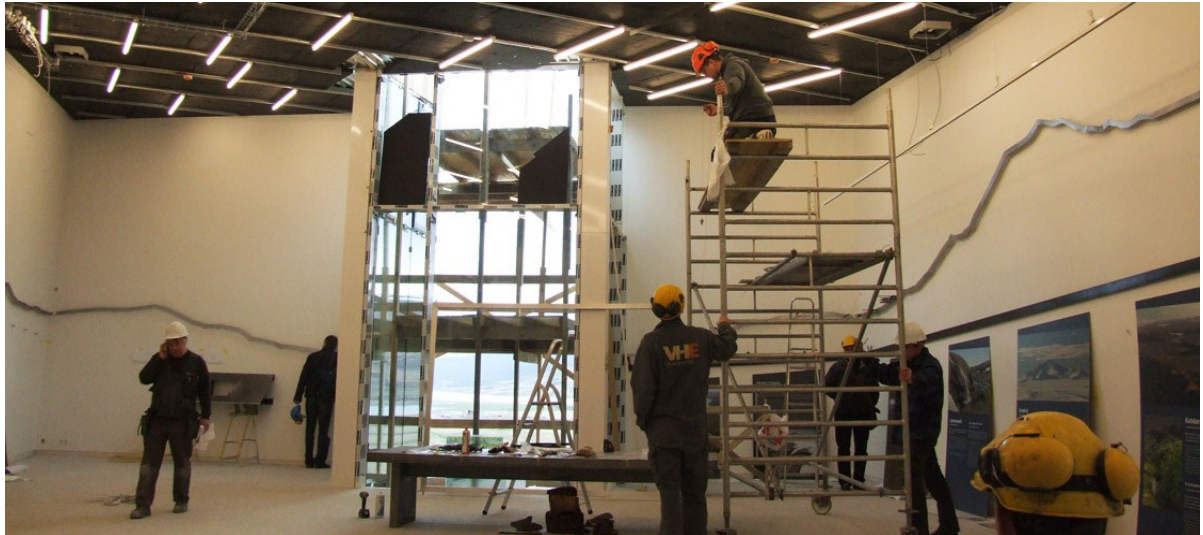
Mynd 28: Unnið við loft í Snæfellsstofu
