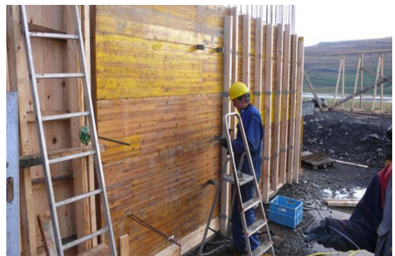
Mynd 20: Unnið að mótauppslætti
