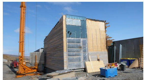
Mynd 27: Byggingin gerð tilbúin fyrir koparklæðningu
